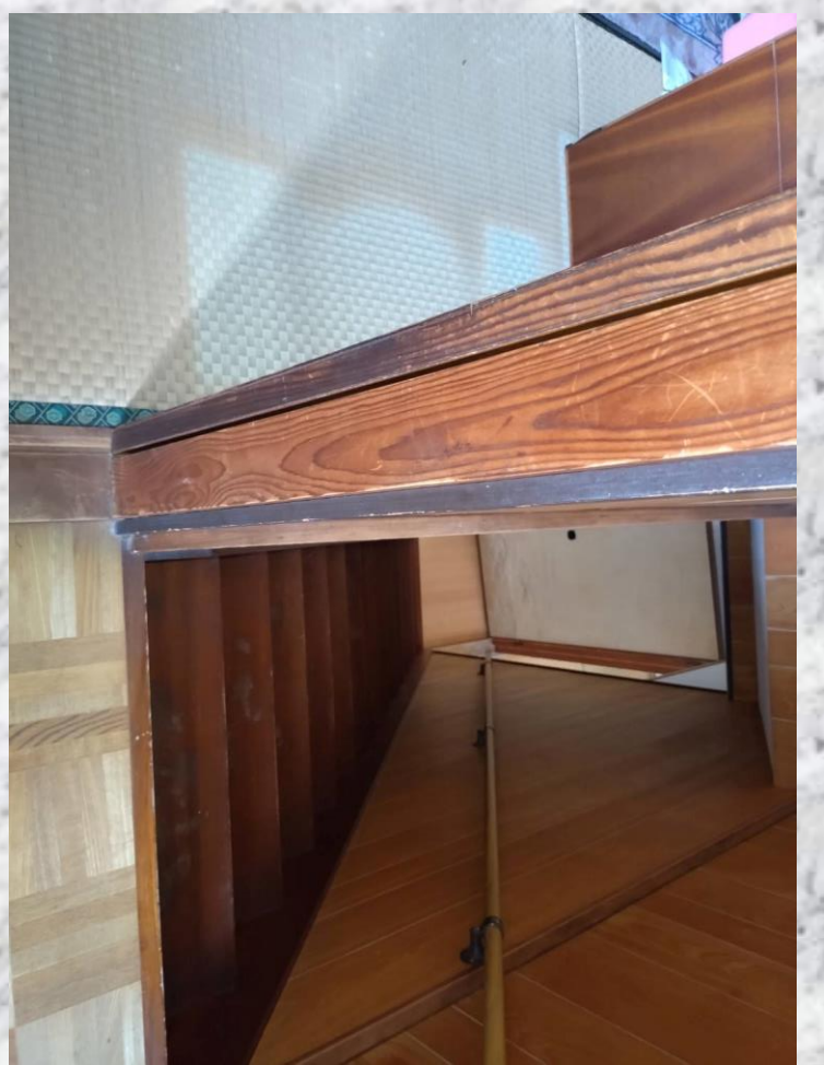
本野町売家①写真㉓：2Fから見た手すり付き階段
